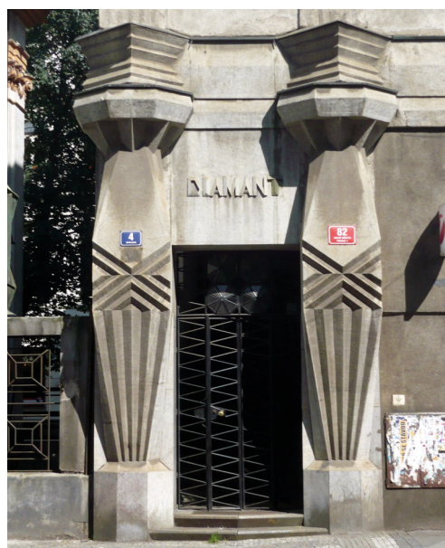
Dům ..... Lazarská ulice 1, Praha, 1912 – 1913, detail
